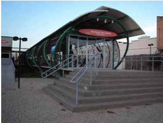
Estação do Metrô do Cariri na cidade do Crato, próximo ao Centro Cultural do Araripe
