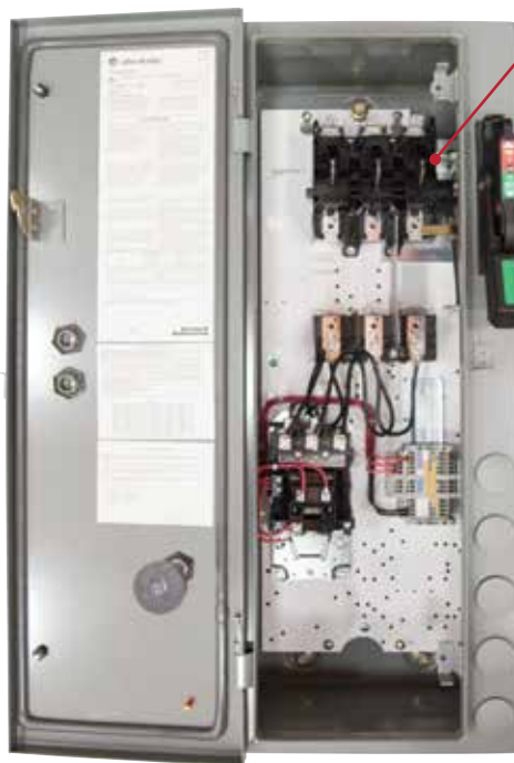
512 Partida direta com chave de seccionadora tipo faca visível
