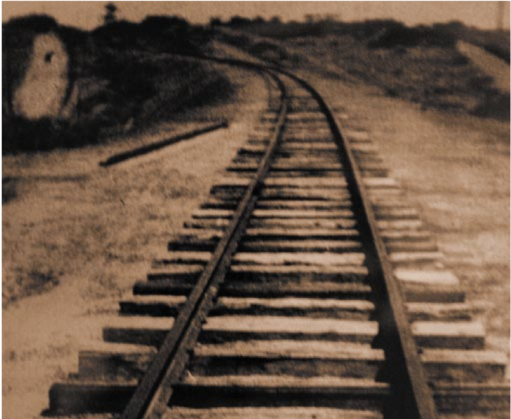
Na 'Madeira-Mamoré' os dormentes são de eucalipto importado da Austrália. The 'Madeira-Mamoré' railroad has railway sleepers made of eucalypts imported from Australia.
