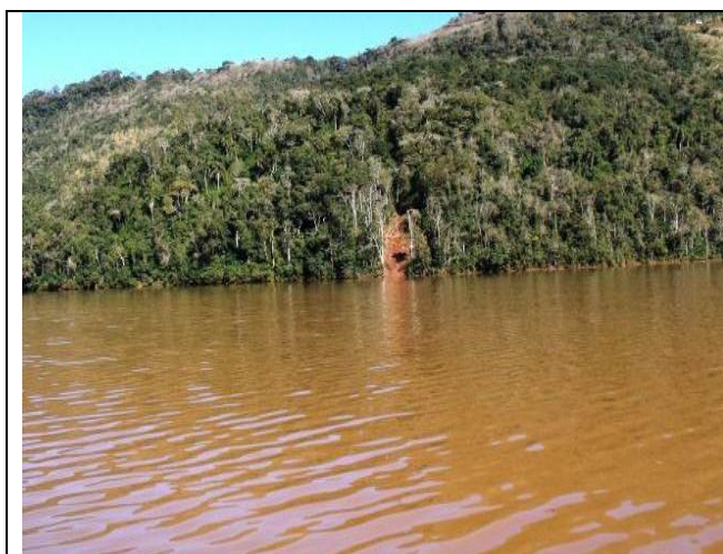
Foto 05– Local com escorregamento, antes das atividades de manutenção.
