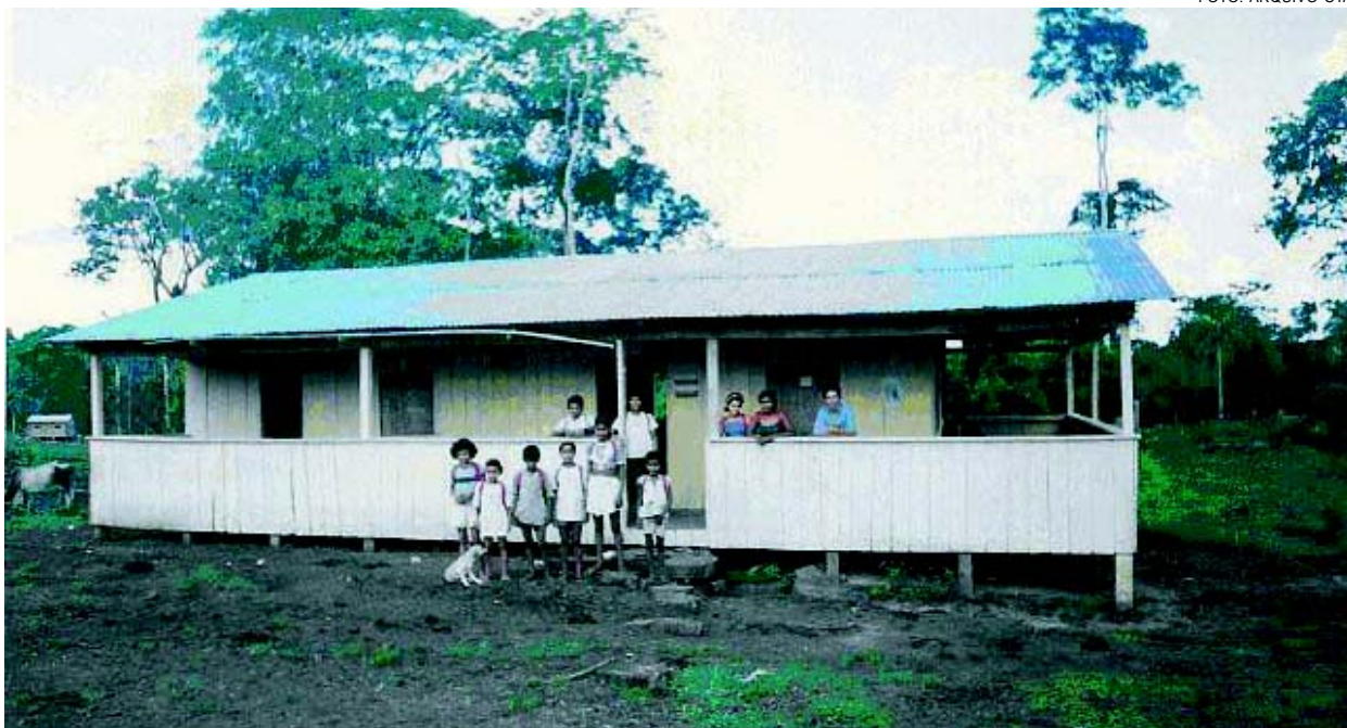
Escola Boa Vista, construída na terceira fase do Projeto de Educação do Seringueiros
