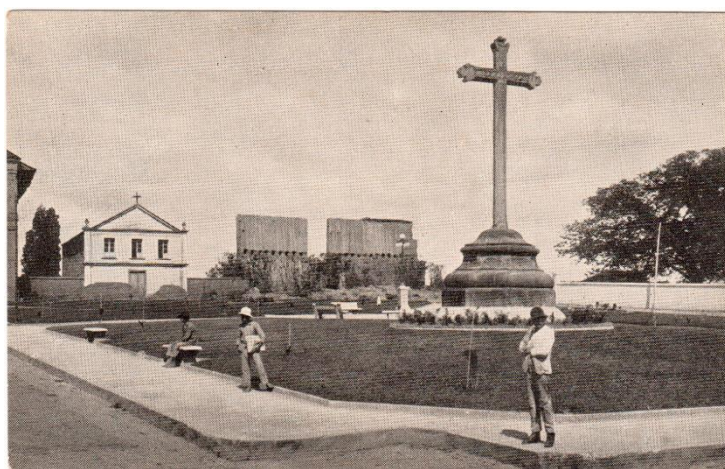
Aspecto do Cruzeiro e do Convento de São Luiz, em ruínas após o incêndio.
